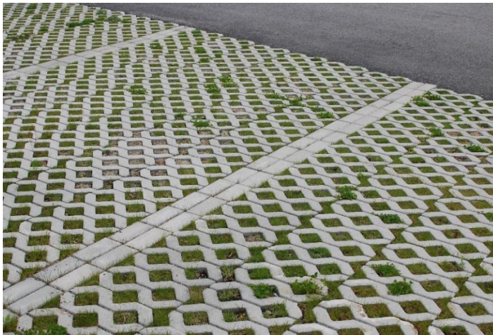
Figur 20. Exempel på vattengenomsläpplig beläggning på parkering. Foto: Sweco
