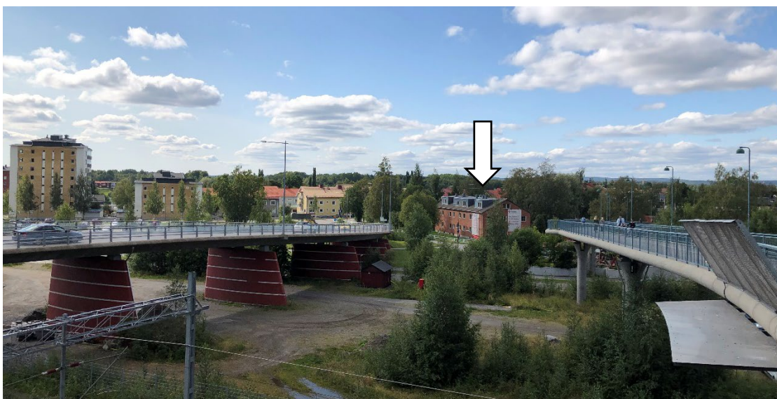
Vy över planområdet från nordväst med broanläggningen Sjukhusbacken (till vänster) och cykelbron Svingen (till höger). Foto: Tyréns.
