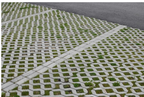
Figur 11. Figuren visar ett foto av en parkering med hålsten.
