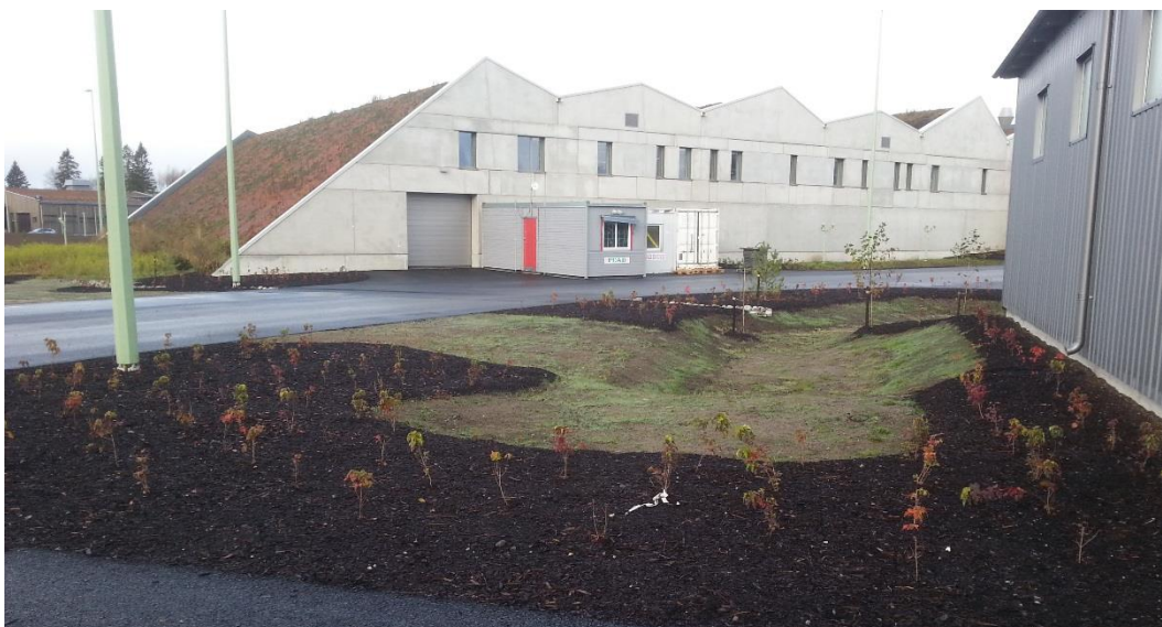
Figur 16: LOD-anläggning vid reningsverket på Ön
