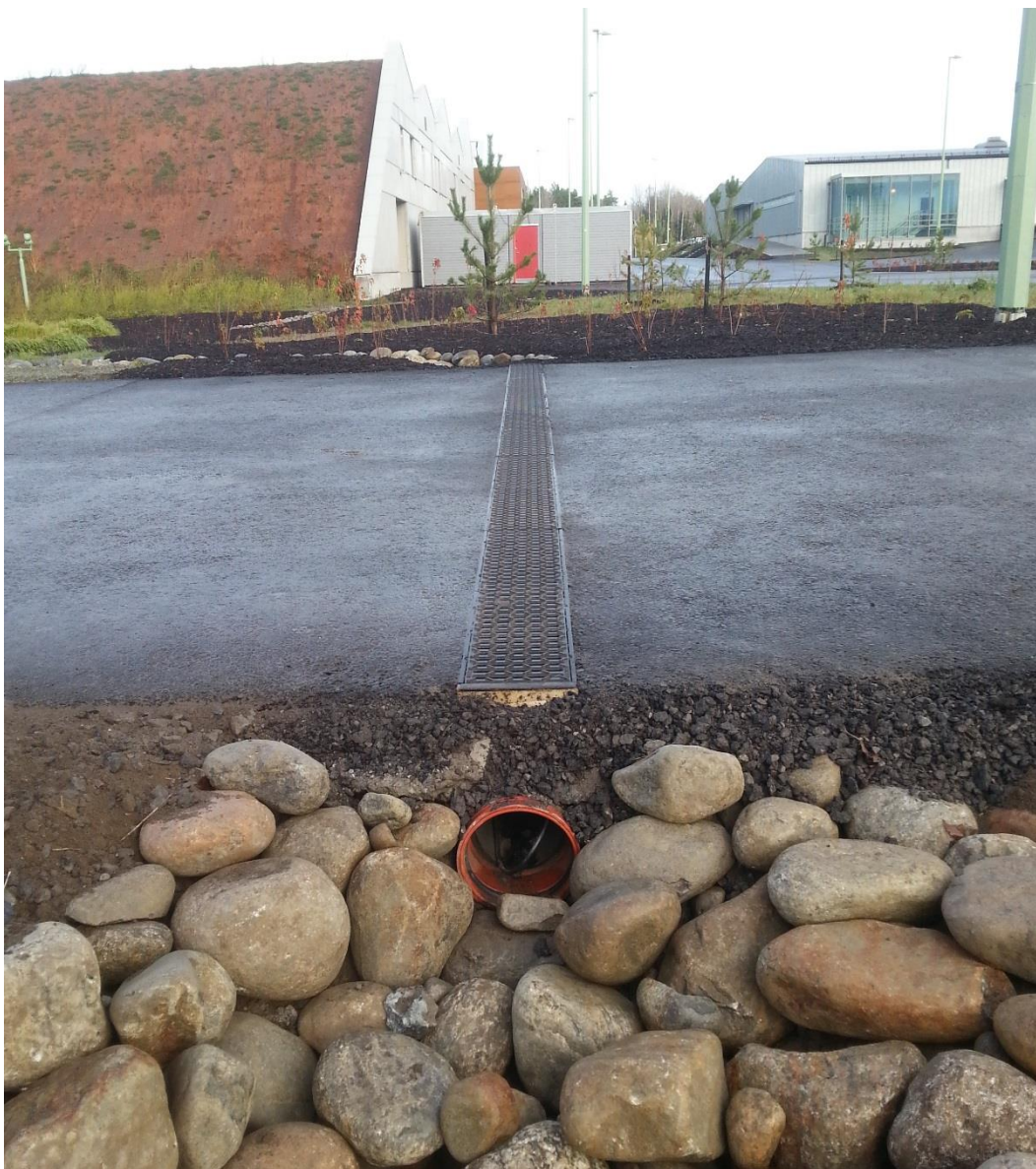
Figur 17: Dagvattenränna där dagvattenstråket kan korsa vägbanan
