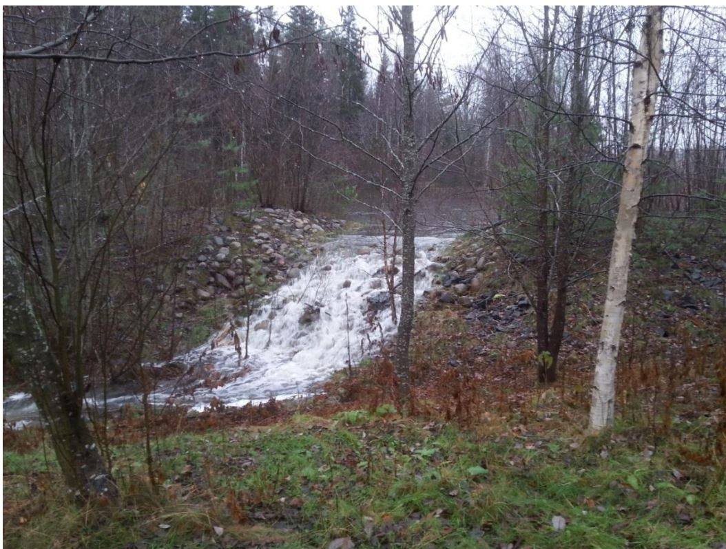
Figur 2: Bräddutloppet ur Olofsdalsmagasinet vid ett långvarigt, men lågintensivt regn
