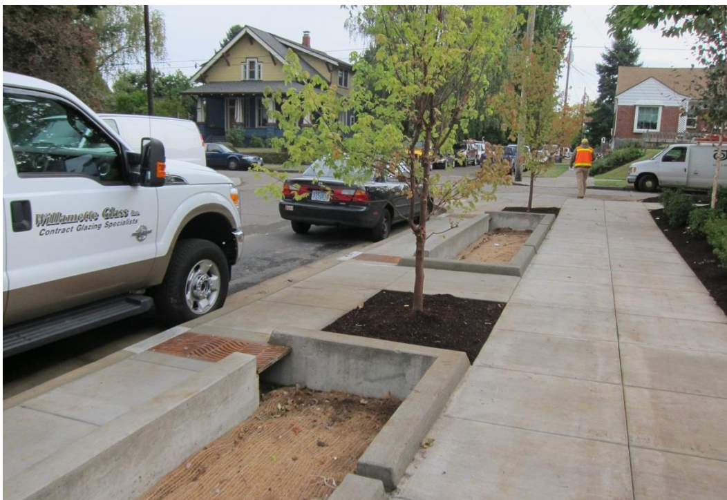
Figur 18: Exempel på dagvattenmagasin under uppförande mellan gata och trottoar.
