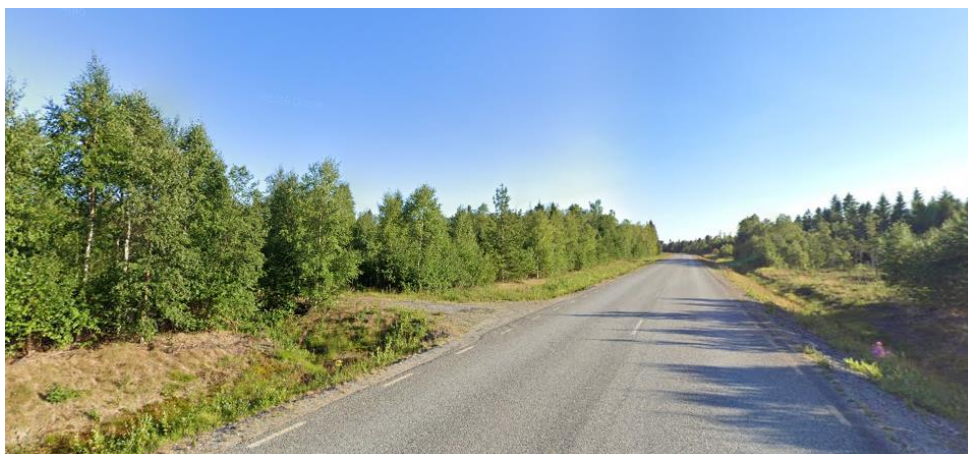
Figur 10. Vy från norr som visar sträckan längs väg 649 (Sävarvägen) där ny in-/utfart möjliggörs söder om befintlig infart.
