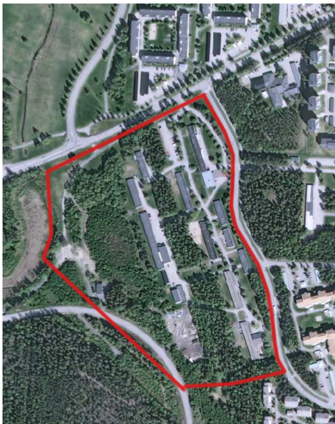
Översiktsbild över Stadsliden 6:2.
