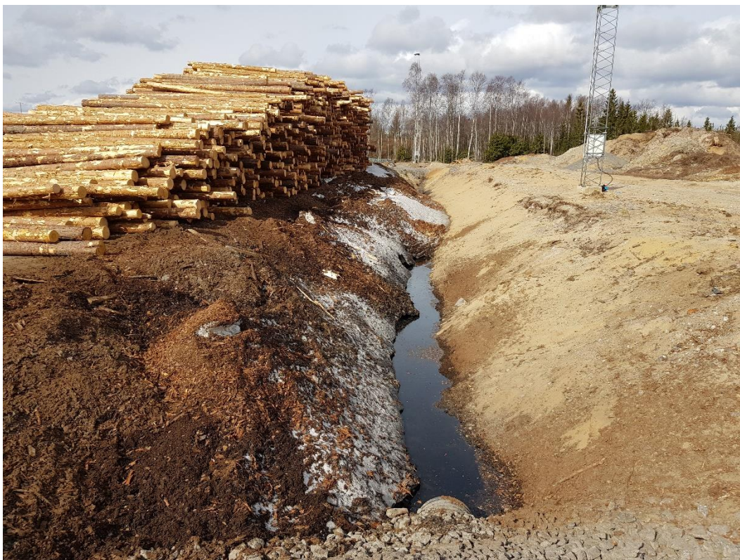
Figur 4. Diket vid den norra kanten av timmerplanen. Till vänster; huvudsakligen underlag av snö med mindre mängd lös bark ovanpå. Till höger i bild syns sandig mark.
