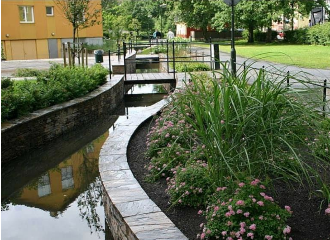
Figur 17. Stensatt kanal för dagvatten (Foto av Tomas Leidstedt, 2014).
