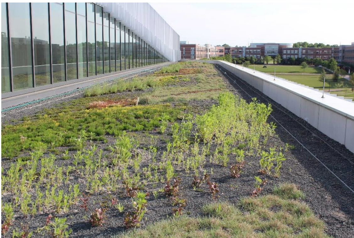
Figur 19. Exempel på grönt tak (Foto av Søberg, 2014).
