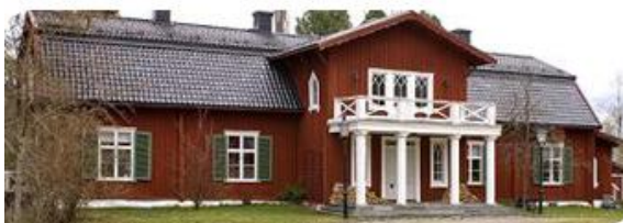
Byggnadsminnet Böle boställe ligger i närheten om planområdet, norr om Bölevägen.
