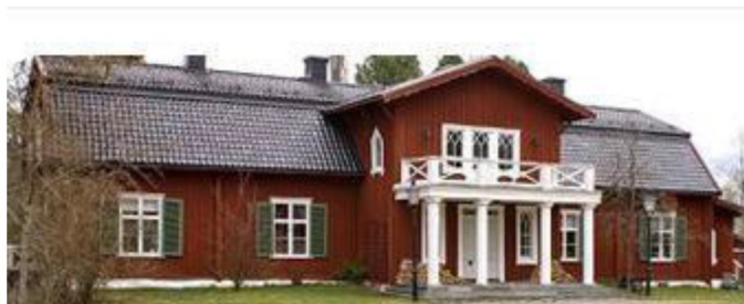
Figur 8. Byggnadsminnet Böle boställe är beläget nordost om planområdet.
