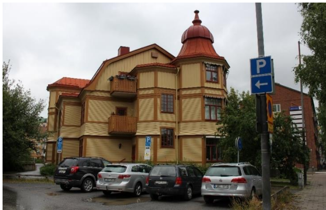
Figur 23. Byggnader inom fastigheten Arken 10, nordost om kvarteret Skruven. Foto: Victoria Bly, Tyréns AB 2019.
