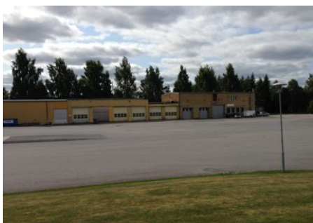
Byggnader vid södra fastighetsgränsen, som föreslås rivas.
