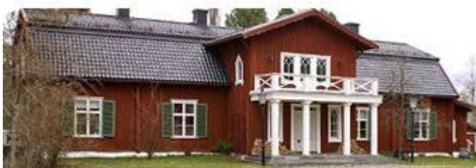
Figur 6. Byggnadsminnet Böle boställe är beläget nordost om planområdet.
