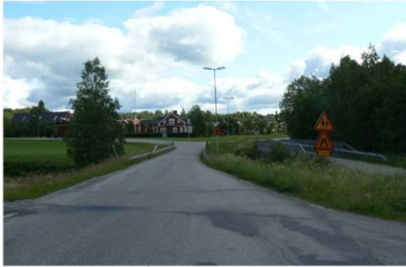
Infart till Ersmark på Söndagsvägen. Väg för biltrafik har endast ett körfält. Separat bro för GC till höger.
