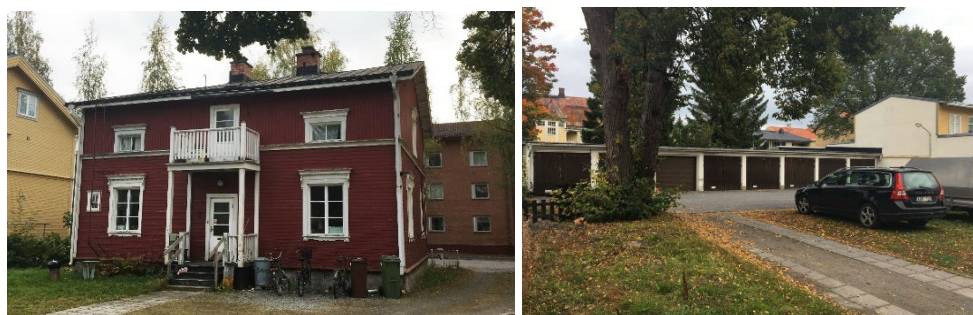
Figur 5. T.v. gathuset sett från gården, t.h. garagelängan i norra fastighetsgränsen, sedd från infarten.
