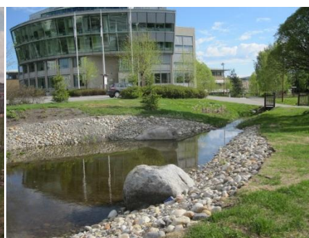
Figur 19. Damm/dike med erosionsskyddade slänter (Bild: WSP, Umeå)
