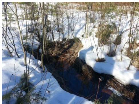
Figur 7. Ganska Stillastående vatten vid dagvattenutlopp
