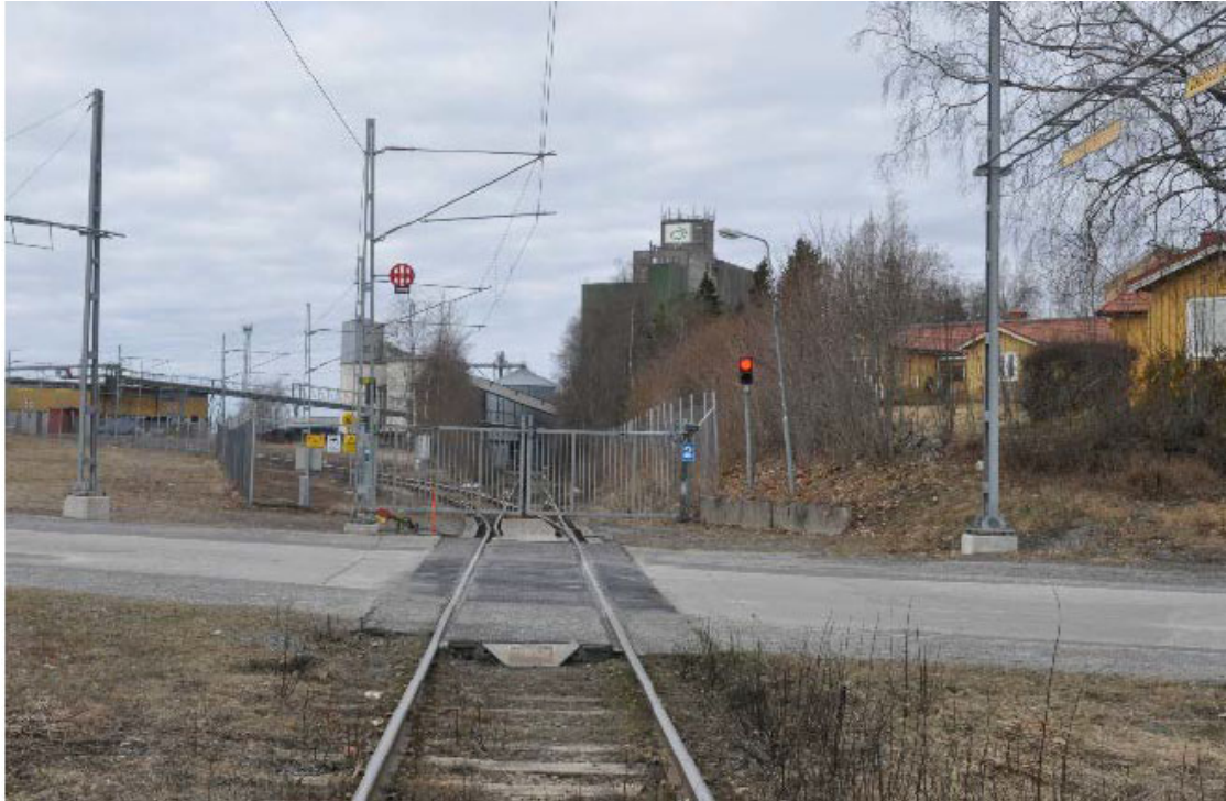
Järnvägs korsning vid Axel Enströms väg.
