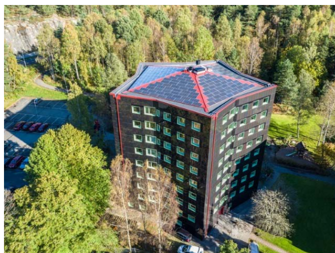
Figur 2 Bild av kollektivhuset Stacken efter energirenovering. Foto: Christian Badenfelt
